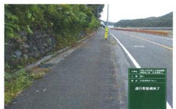
歩道整備完了
